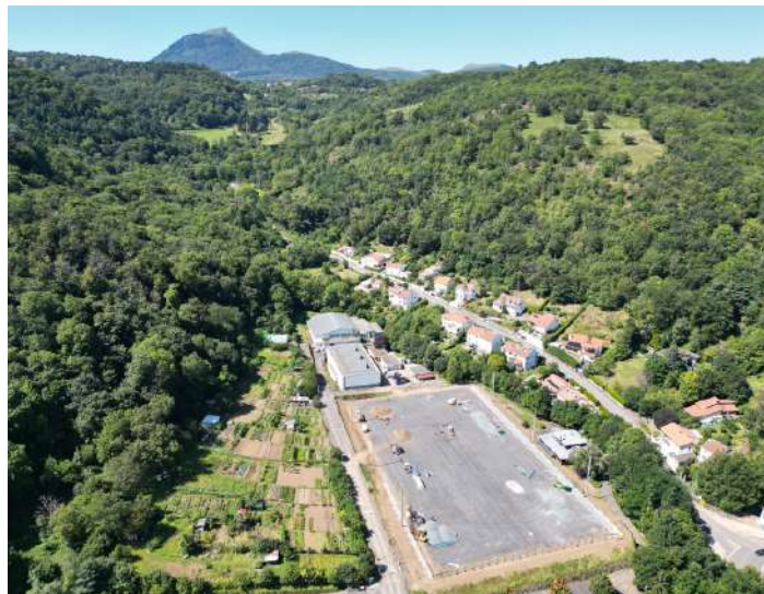
Terrain pendant les travaux
