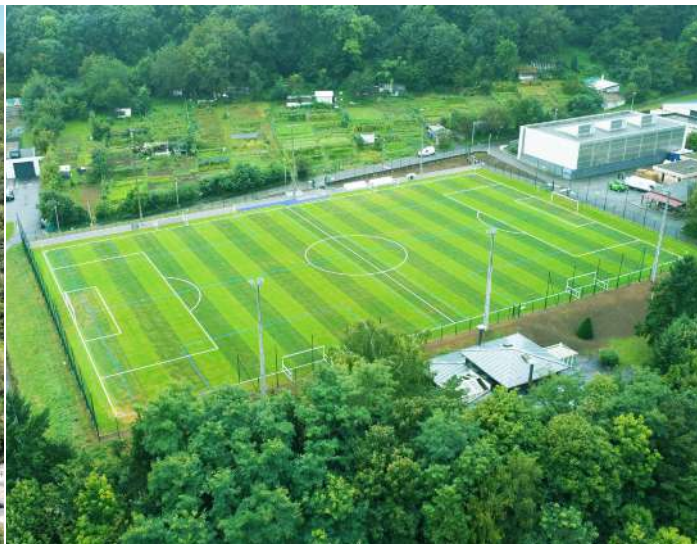
Terrain après les travaux
