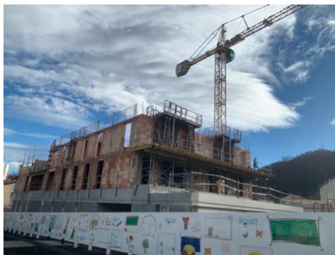
Le chantier en décembre 2024
